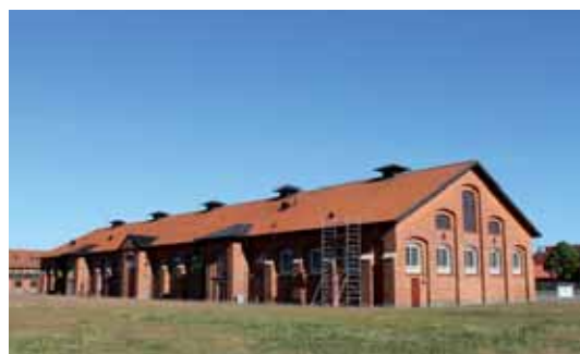
Byggnad inom den södra delen av programområdet. Byggnad 6. Foto: Ystads kommun
