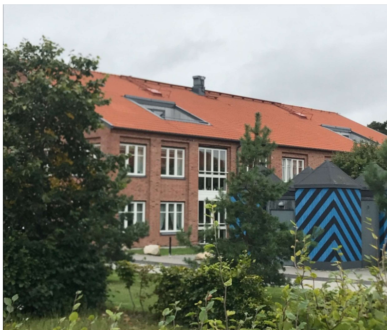
Exempel på takterrass infälld i takfallet (Malmö 4) Foto Björn Johansson
