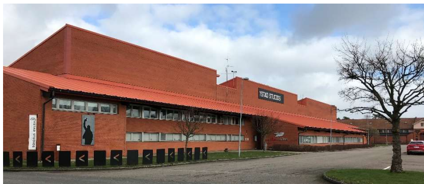
Före detta luftvärnshall (nuvarande Ystad studios) Foto Ystads kommun
